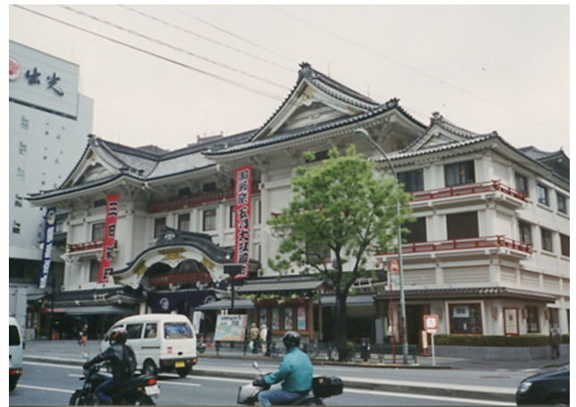
図28 現在の歌舞伎座(改修清水建設)
