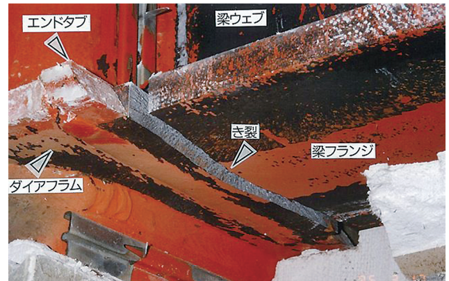
図27 兵庫県南部地震で鉄骨造の被害がクローズアップ(寺田岳彦氏提供)
