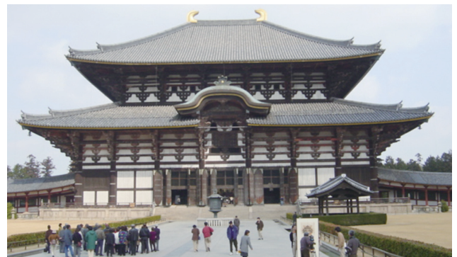
図9 東大寺大仏殿(高さ47.5m、東西57m)
