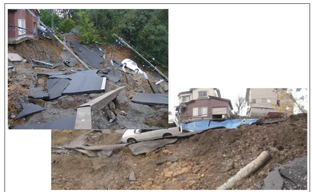
図18 2004年新潟県中越地震地盤被害(清水建設提供)
