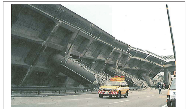
図16 1995年兵庫県南部地震 高速道路被害(清水建設提供)
