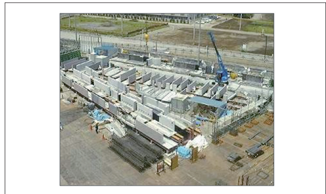
図48 サイトPC工法は全自動工法の「現場の工場化」思想を受け継いだと言える (清水建設提供)
