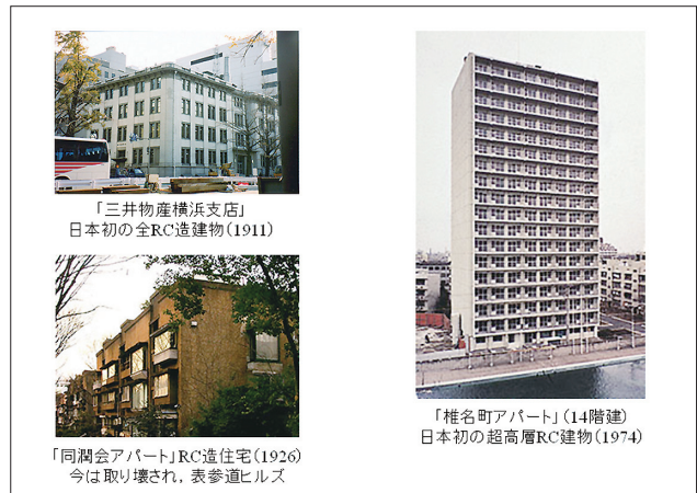
図 32 日本の鉄筋コンクリート造建物(清水建設提供)
