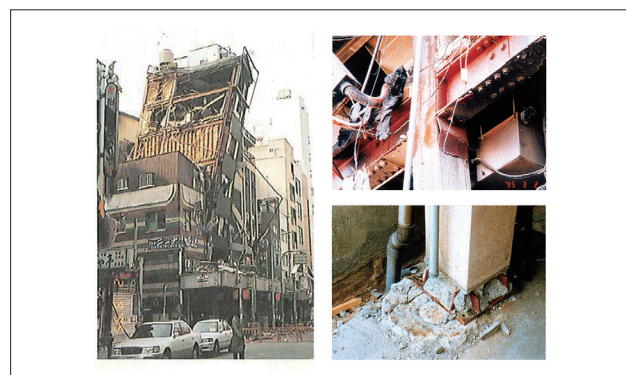
図14 1995年兵庫県南部地震での鉄骨造の被害(清水建設提供)
