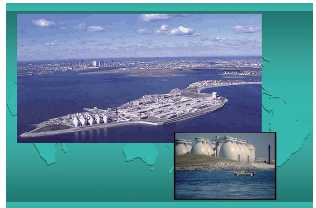
図18 DEER島に浄化施設が建設された (MWRA HPより)
