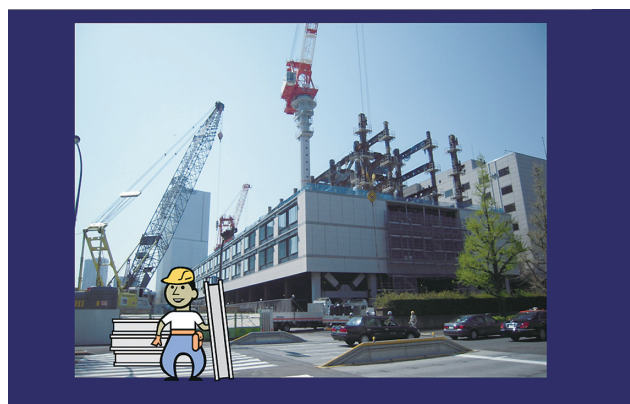
図15 鉄骨造は乾式プレファブ工法
