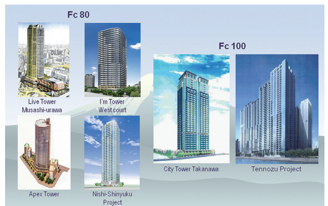
図21 2000年代半ばの高層RCのコンクリート強度は100N/mm 2 クラス(清水建設提供)
