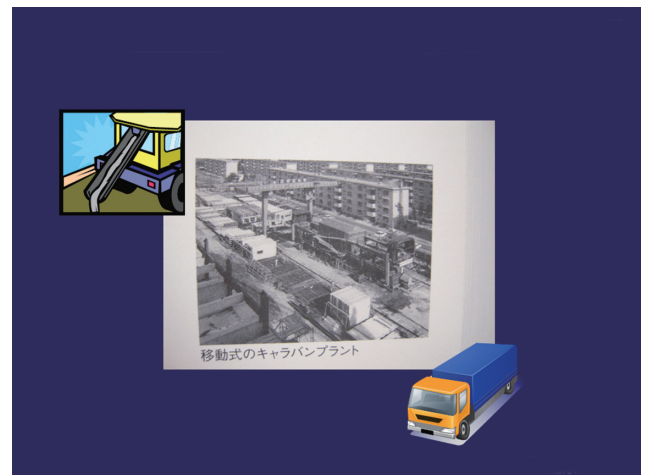
図33 移動式のPC版製造プラント（清水建設提供）
