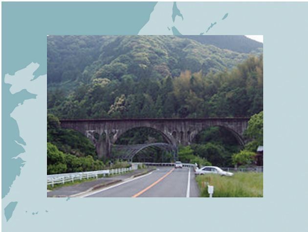
図36 竹筋コンクリートの可能性のある福井川橋梁 (Wikipediaより)
