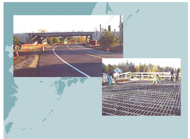
図42 米国ニューハンプシャー州の実橋へのネフマック適用
