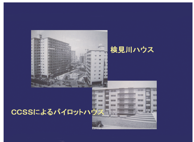
図34 住友検見川ハウスと清水センターコアシステム（CCSS、清水建設提供）
