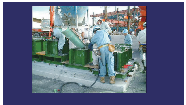
図20 サイトファクトリーによるPC版作成
