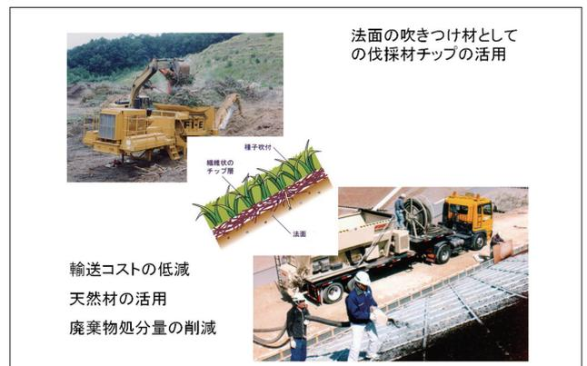
図 44 伐採材の再利用(清水建設提供)
