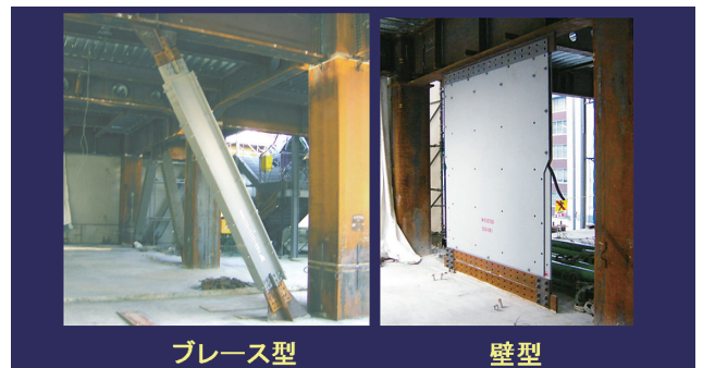
図15 制震ダンパー(粘弾性ダンパー)
