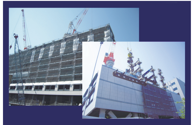
図14 鉄骨工事は日本が世界標準
