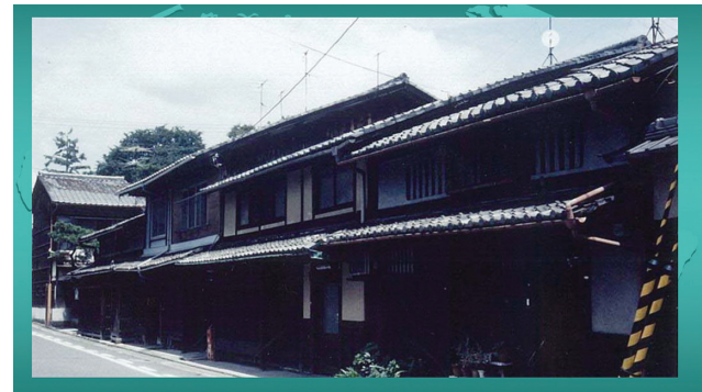
図55 京町家の隣家を保護する屋根・けらば (武庫川女子大学岡崎甚幸教授提供)
