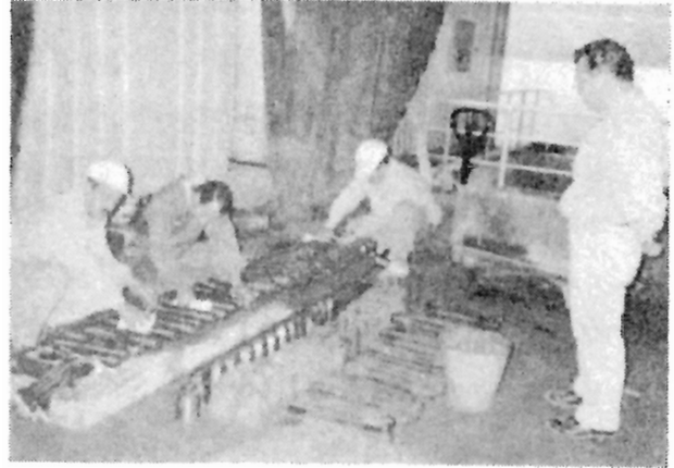
図-1 火力発電所の非破壊検査実施状況
