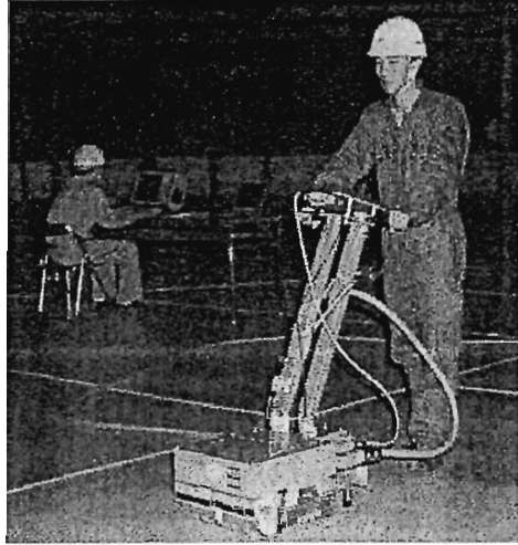
タンク底板面探傷状況
