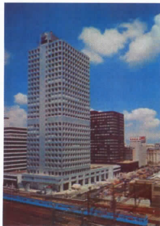
朝日東海ビルディング(1971年) 全面的にUTを採用した初めての建物
