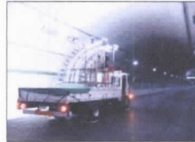
車載カメラでトンネル壁面撮影
