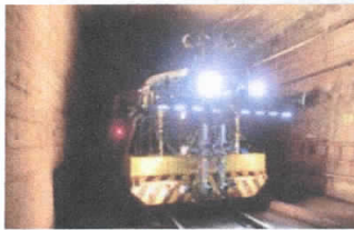
鉄道トンネル モーターカー(時速20km)
