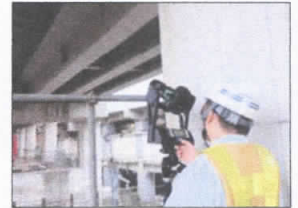
一眼レフカメラで橋梁床版撮影
