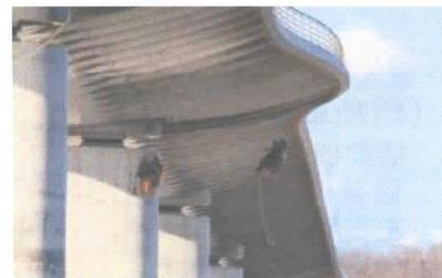
ロープアクセスによる打音検査
